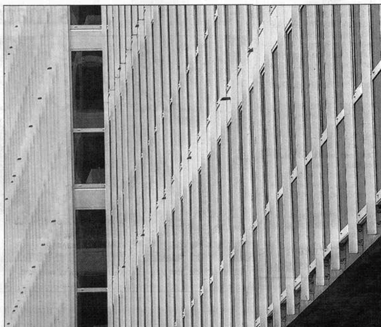
Malgré les rues défoncées et les grues qui continuent d'œuvrer, on commence à deviner l'harmonie future du nouveau quartier de la caserne de Bonne. Le DL / Frédérique VERHAEGHE
